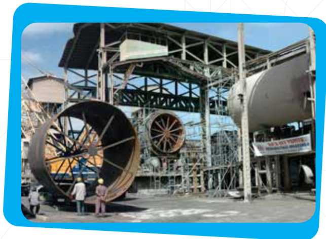
Pembangunan Pabrik Indarung III
