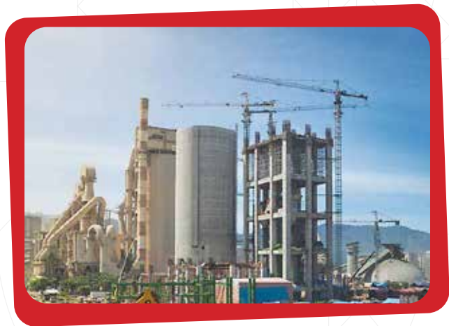
Pembangunan Pabrik Indarung V
