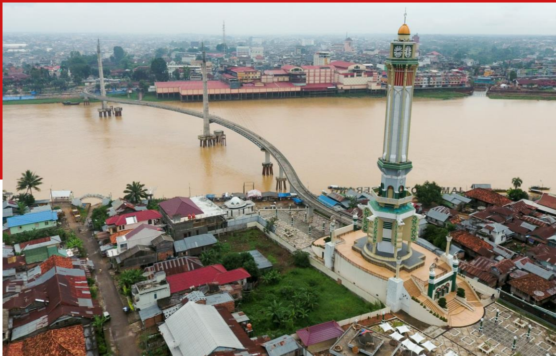
JEMBATAN GENTALA ARASIJAMBI
