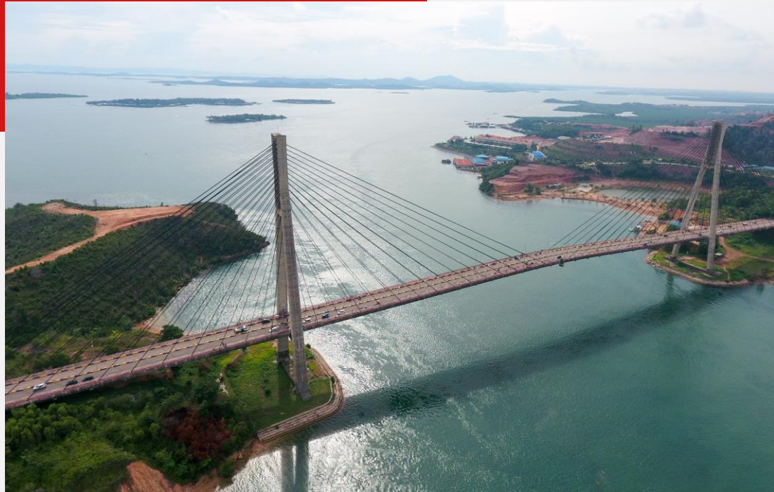
JEMBATAN BARELANG BATAM
